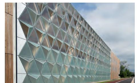
Fachadas espelho sem vista de alumínio; Fachadas com vista de alumínio de 34 mm; Integração homogénea de cassetes de alumínio; Fachadas planas ou de facetas; Fachadas até 6,40 m de altura sem apoio intermédio; Folhas móveis invisíveis: projectante, até 100 kg, e 15° de abertura, abertura de emergência, abertura à inglesa.
