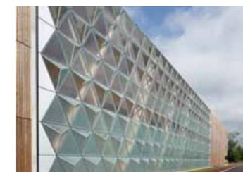
Fachadas espelho sem vista de alumínio; Fachadas com vista de alumínio de 34 mm; Integração homogénea de cassetes de alumínio; Fachadas planas ou de facetas; Fachadas até 6,40m de altura sem apoio intermédio; Folhas móveis invisíveis: projectante, até 100 kg, e 15° de abertura, abertura de emergência, abertura à inglesa.
